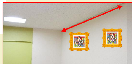
④ 地域ケアルーム前 (エレベーター側)
